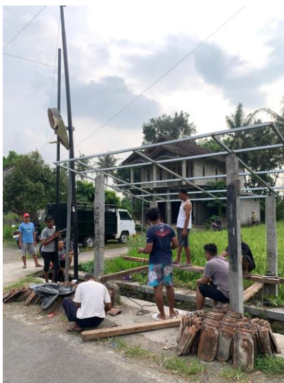
Gambar 6. Kegiatan pembuatan & pemasangan Pos Kampling
